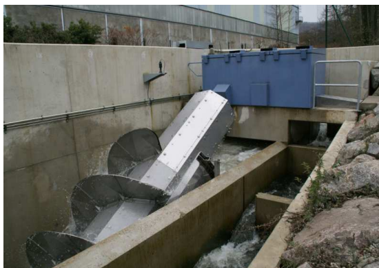
Figure 4 : vis hydrodynamique et son auge
